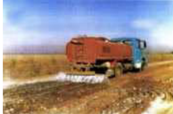
2 Arrosage appliqué avec Rocamix®
