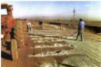
4 Tout le long de la route distribution du contenu des sacs (l'exemple est sans mécanisation)
