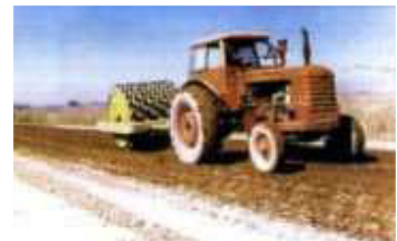
6 Compactage du sol avec rouleau "patte de chèvre" (Quand cela est nécessaire)
