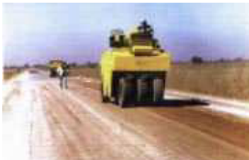
7 Compactage final avec un rouleau pneumatique
