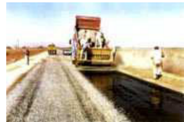
9 Épandage de fines graves sur le traitement asphaltique
