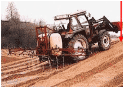
Répartition de Rocamix® (liquide) avec un camion-citerne ou un tracteur+citerne
