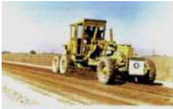
1 Création de la forme de la route et scarification du sol
