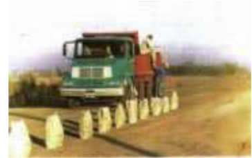
3 Distribution des sacs de ciment selon la quantité prévue (l'exemple est sans mécanisation)
