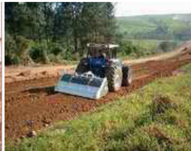
Répartition du Ciment ou Chaux (solide) + Mélange des produits avec un tracteur+disque ou tracteur+rotavator
