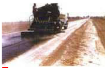
8 Traitement superficiel avec épandage aspartique type R-1
